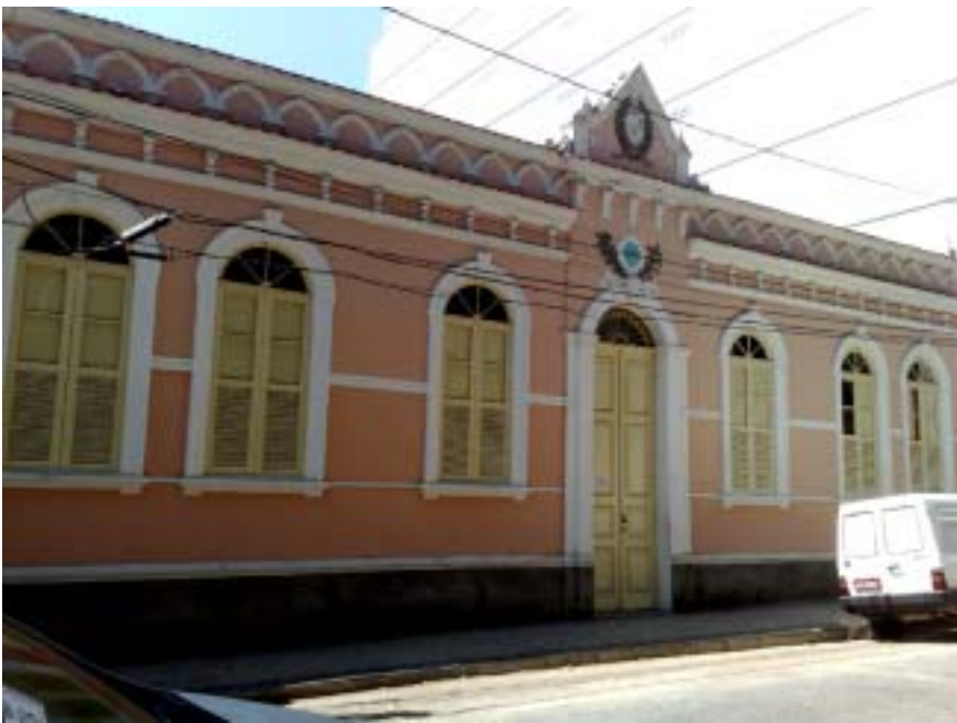
Atual sede da Biblioteca Municipal, onde se está construindo o CENTRO CULTURAL AMÉLIA THOMAZ.
