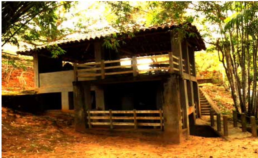
Aqui é abrigado o gerador de energia elétrica, movido pela turbina da foto acima. O dr. Tarcísio dotou a fazenda dos recursos da modernidade. Foto CEPEC 2013.
