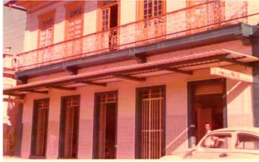
Prédio onde Jovelino instalou o Mercado PAG-LEV
