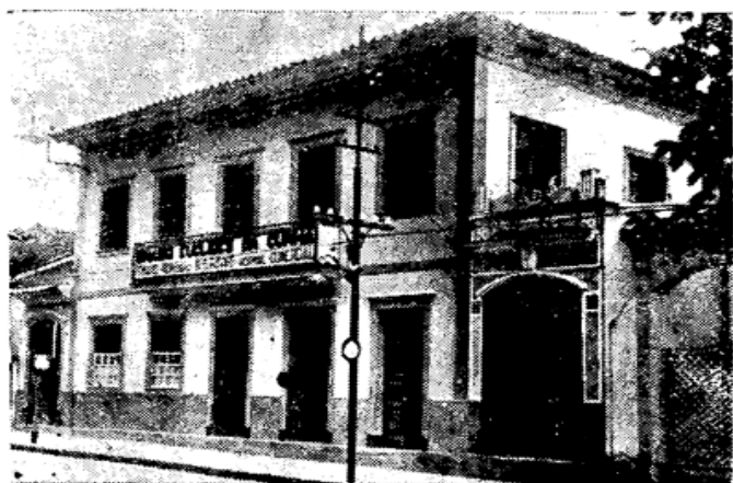
O velho prédio onde funciona o CEC.
