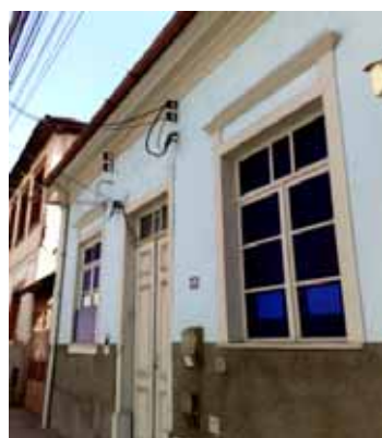
fachada do prédio
